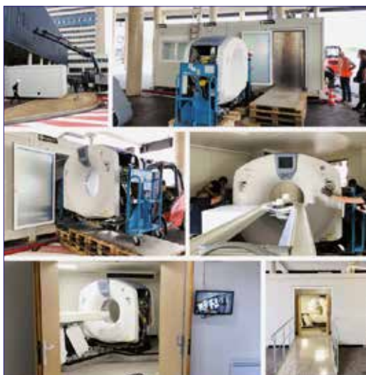
Installation du premier CT in a box de GE Healthcare à l'Hôpital Henri-Mondor AP-HP de Créteil
